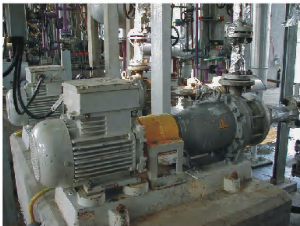
TDI 光气输送泵 TDI Phosgene transmission pump 产能 : 7万吨/年 Capacity : 70kt/a
