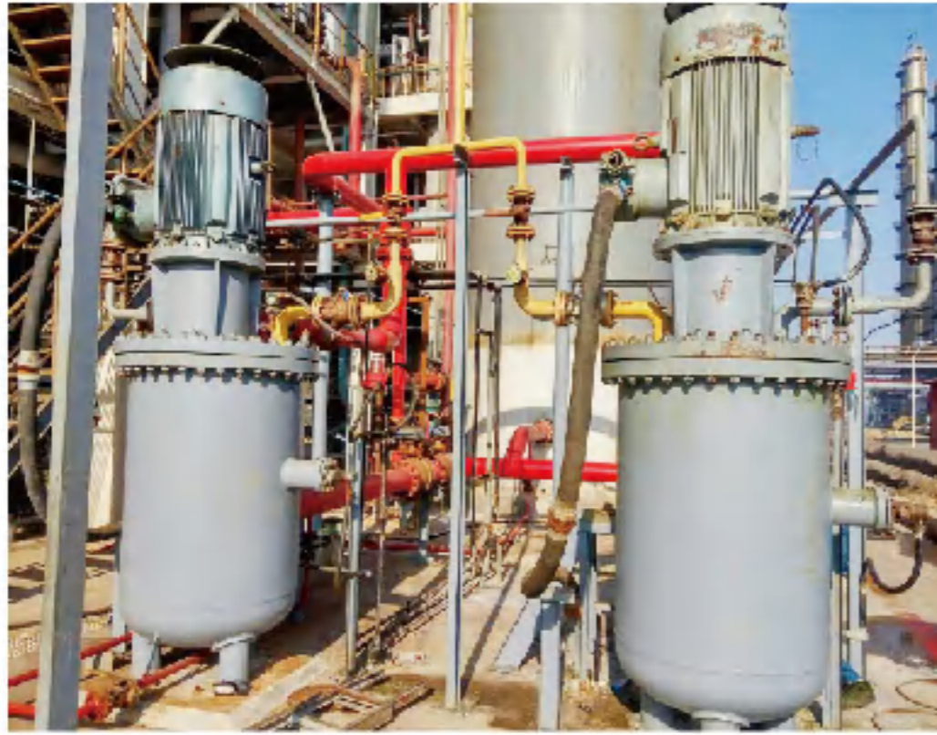
多晶硅 四氯化硅输送泵 Pump for SiCl 4 project for Polycrystalline Silicon 流量Q : 170m 3 /h 扬程H : 95m 功率P : 110KW
