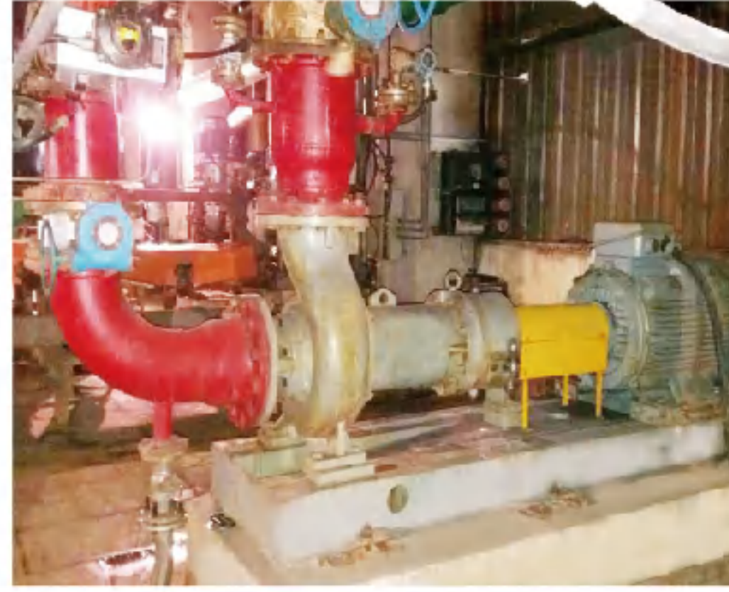
四氯化钛循环泵 Transfer pump for TiCl_4 circulation 流量Q : 400m 3 /h 扬程H : 53m
