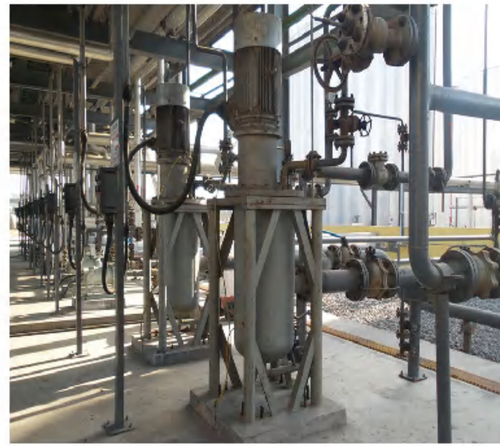
环氧丙烷项目 丙烯输送泵 Pump for C_3H_6 in Propylene epoxide project 产能 : 8万吨/年 Capacity: 80kt/a
